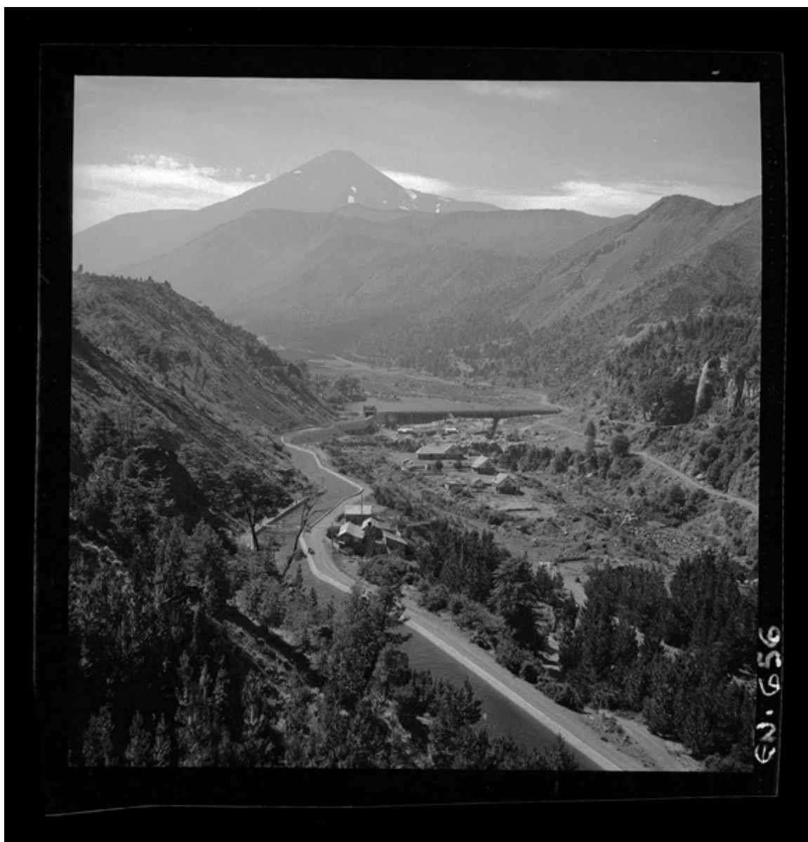
Bocatoma, barrera de 150 m. de largo, provista de compuertas que atajan el río Laja y desvían su caudal hacia
