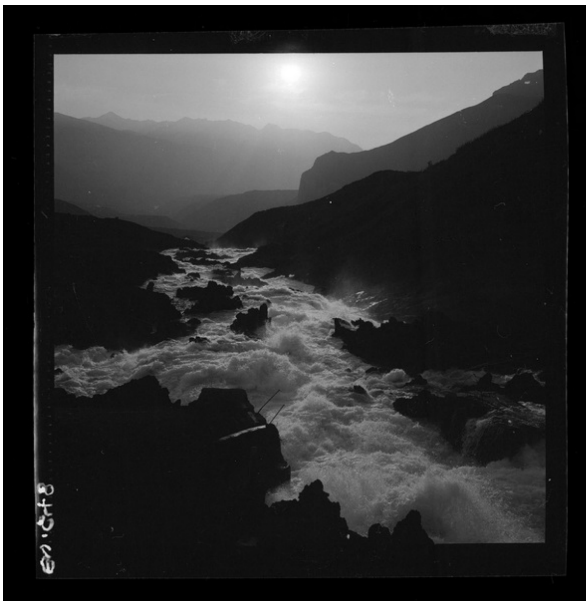
Obras de captación en la Laguna de La Laja [fotografía] Luis Ladrón de Guevara.
