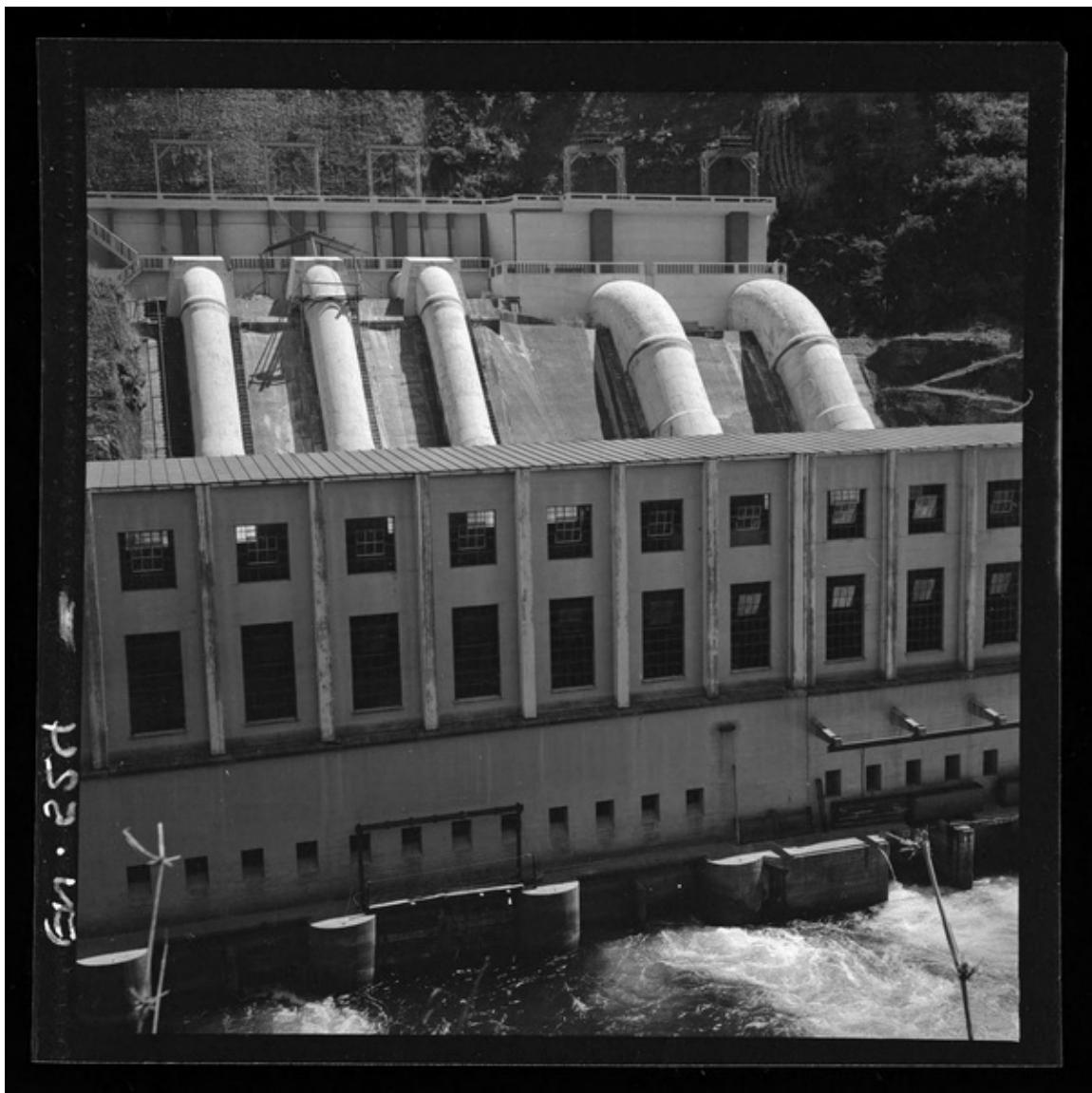
**Aspectos de la central y su entorno : edificio de 10.000 m<sup>2</sup> y las 5 tuberías de 52 m. de longitud, 3 de ellas tienen 2,30 m. de diámetro y las restantes 3,70 m. diámetro [fotografía]**
