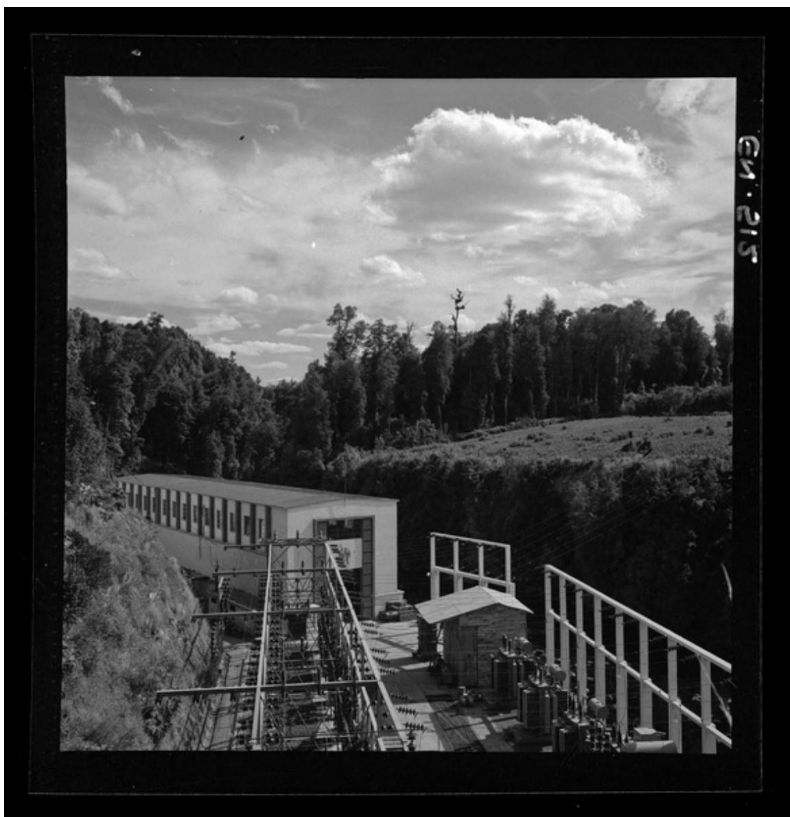
[Vista de la Central "Pilmaiquén" y su entorno] [fotografía] Luis Ladrón de Guevara.
