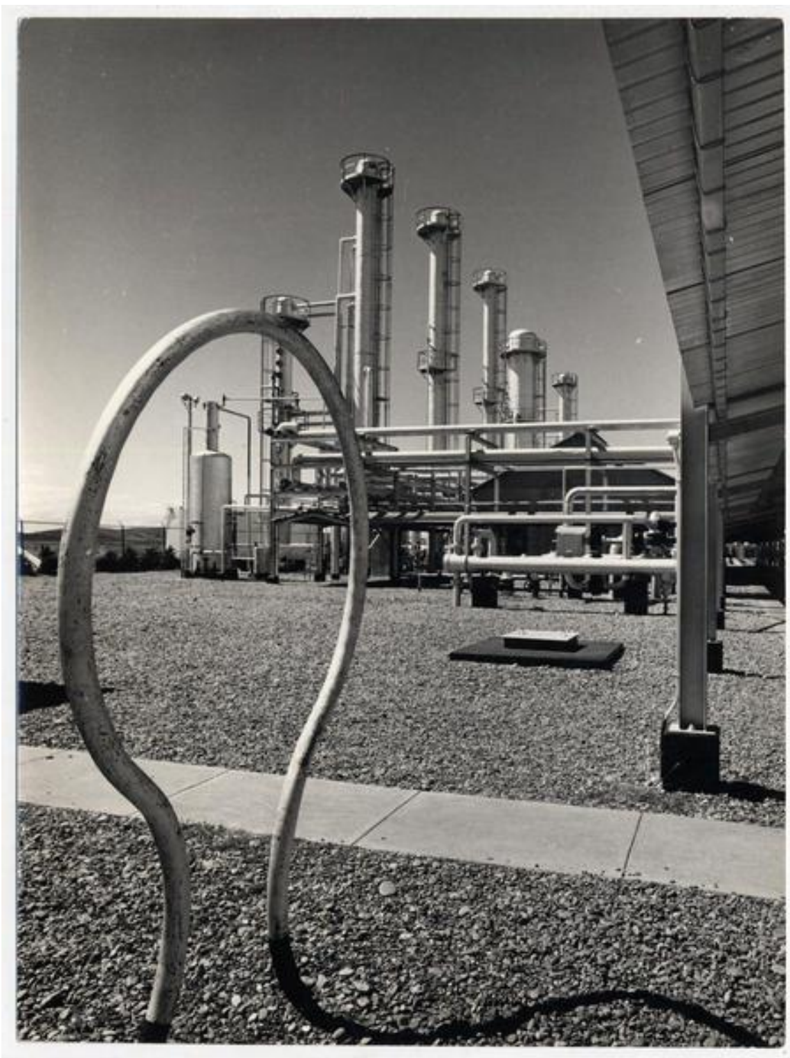
[Tierra del Fuego: torres de absorción, planta de gas en Manantiales] [fotografía] Antonio Quintana.
