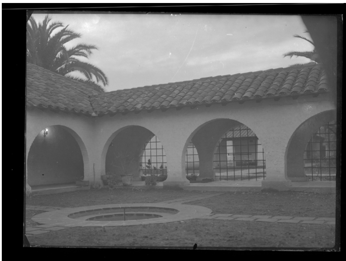
[Corredor interior de la residencia Linderos] [fotografía] Alfredo Molina Lahitte.
