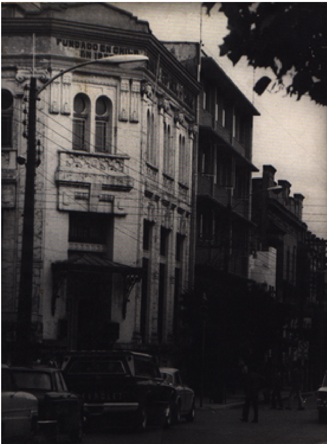
Edificio del Banco Español. Bulnes con Antonio Varas
