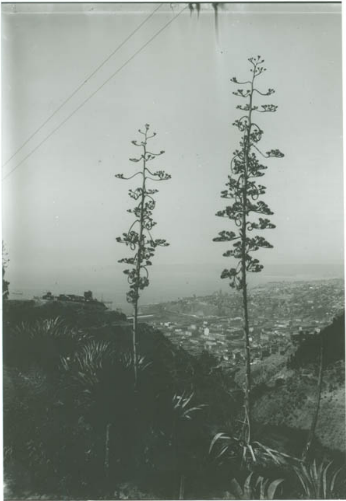
PANORAMICA DE VALPARAISO.FOT.ALTSCHWAGER
