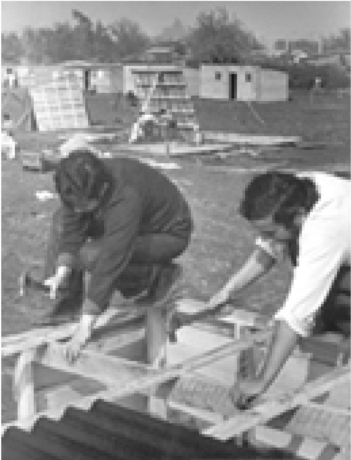
Chile, Trabajos Voluntarios, 1972
