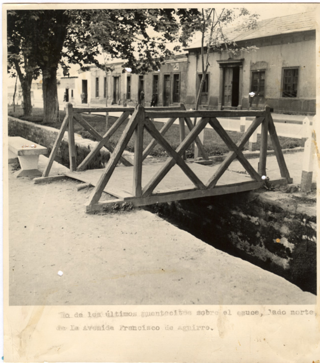
Puentecito sobre cauce de la Alameda de La Serena
