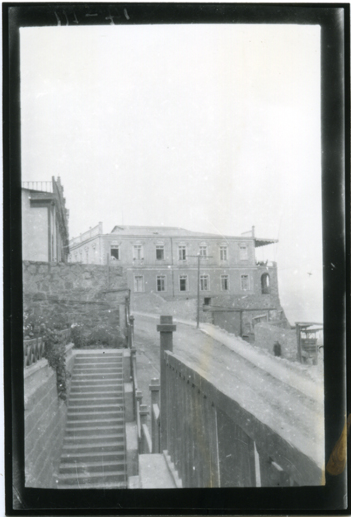
Vista a calle de Coquimbo, 1931
