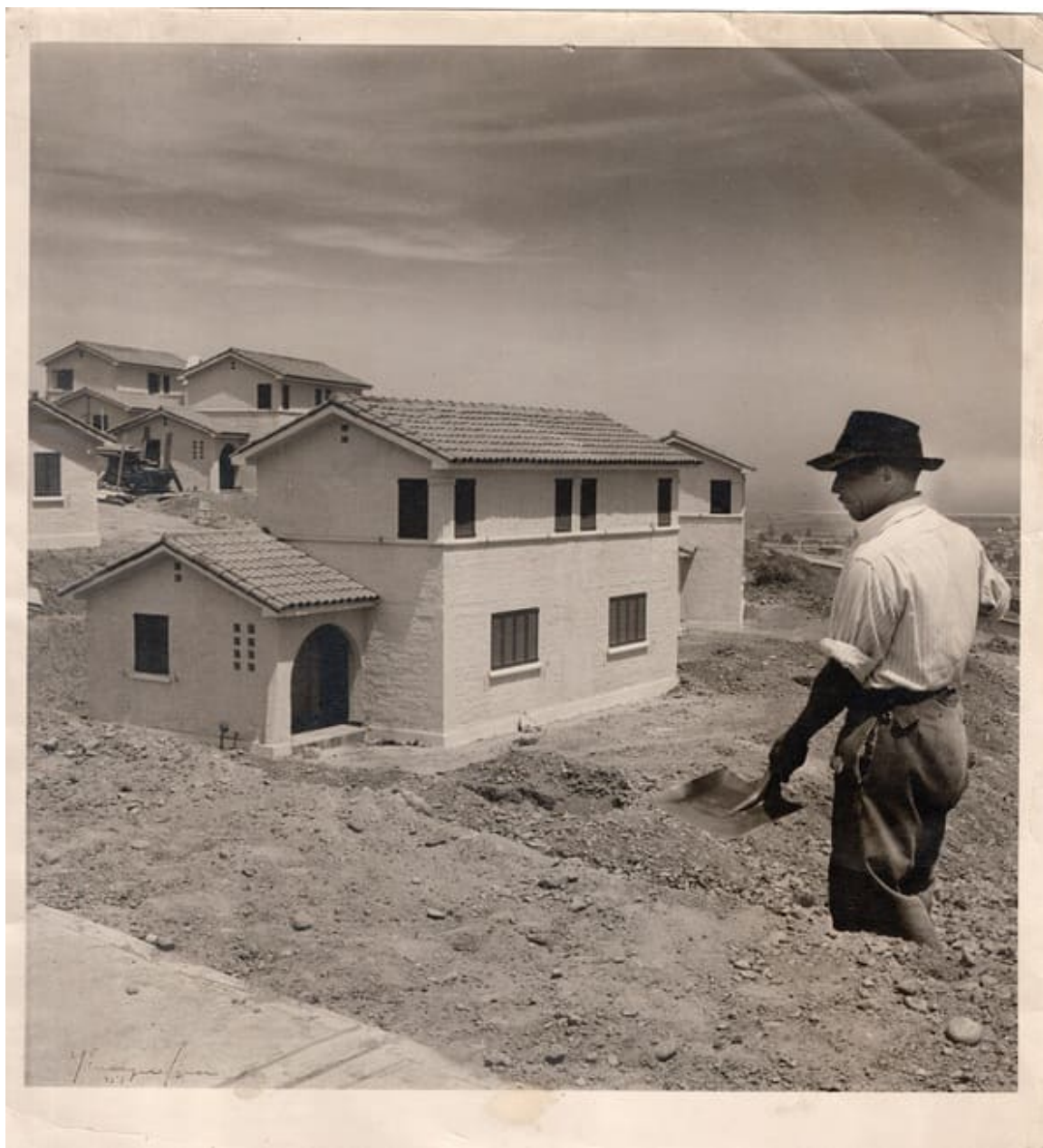
Complejo habitacional de La Serena en etapa constructiva
