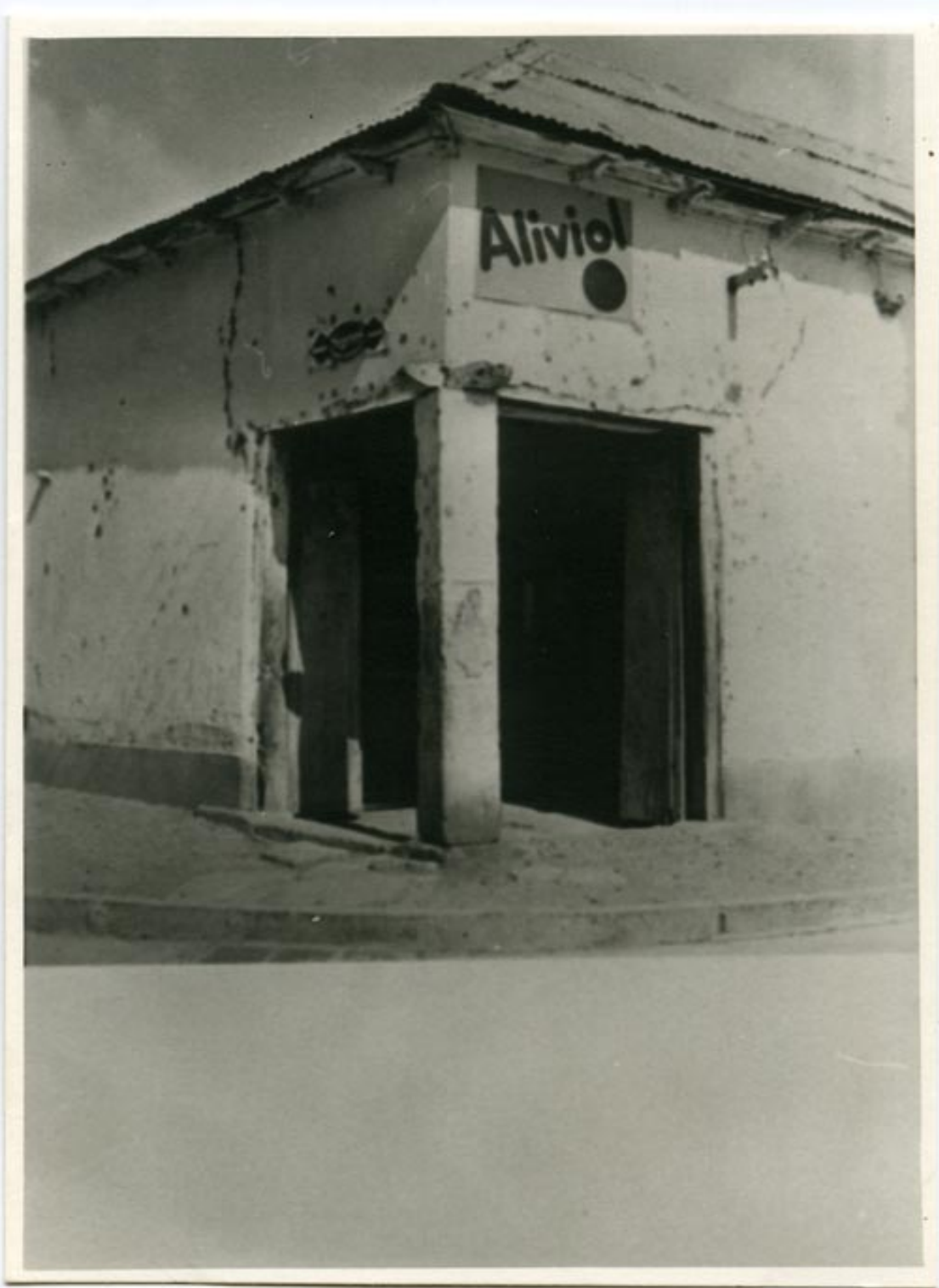
Casa de pilar de esquina de La Serena
