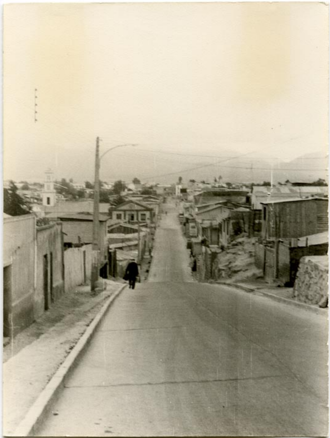
Vista a calle de Coquimbo
