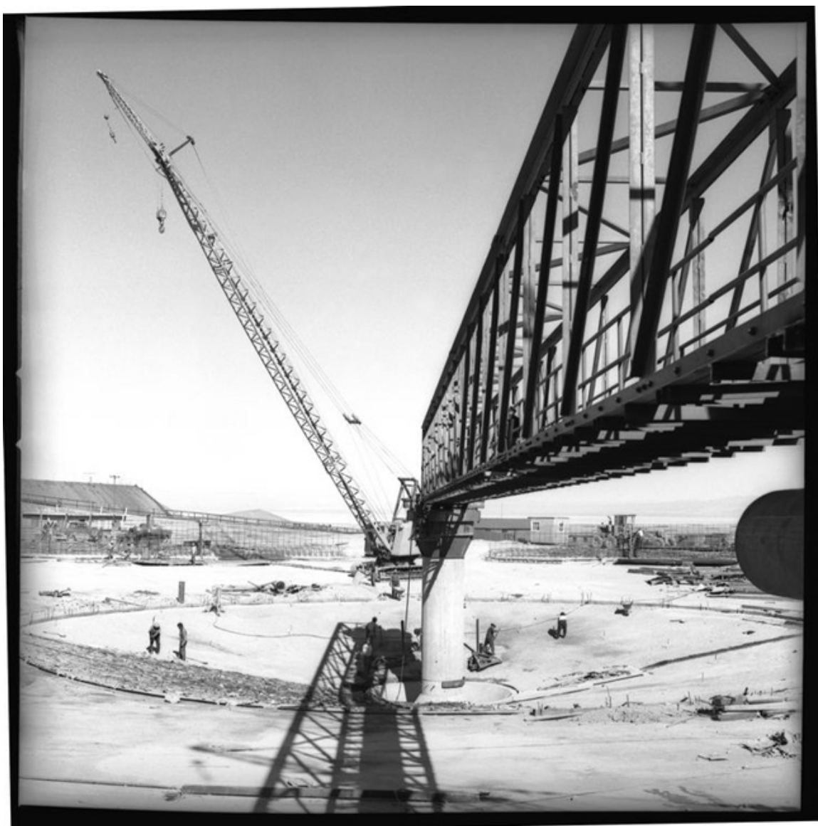
Construcción de un “espesador”. CODELCO.
