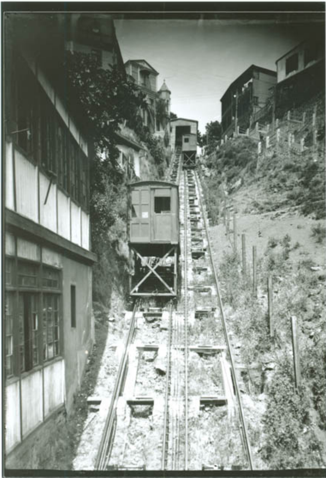
ASCENSORES, VALPARAISO. FOT. ALTSCHWAGER.
