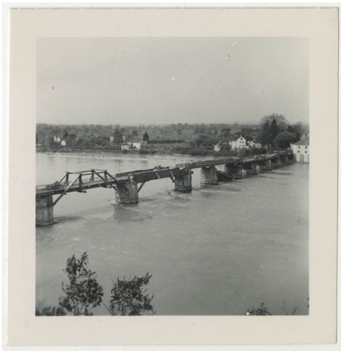
PUENTE SOBRE EL DANUBIO, LINZ, AUSTRIA
