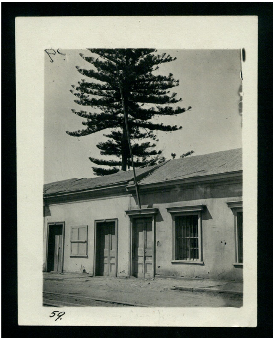
Los Carrera N° 1026, fachada exterior
