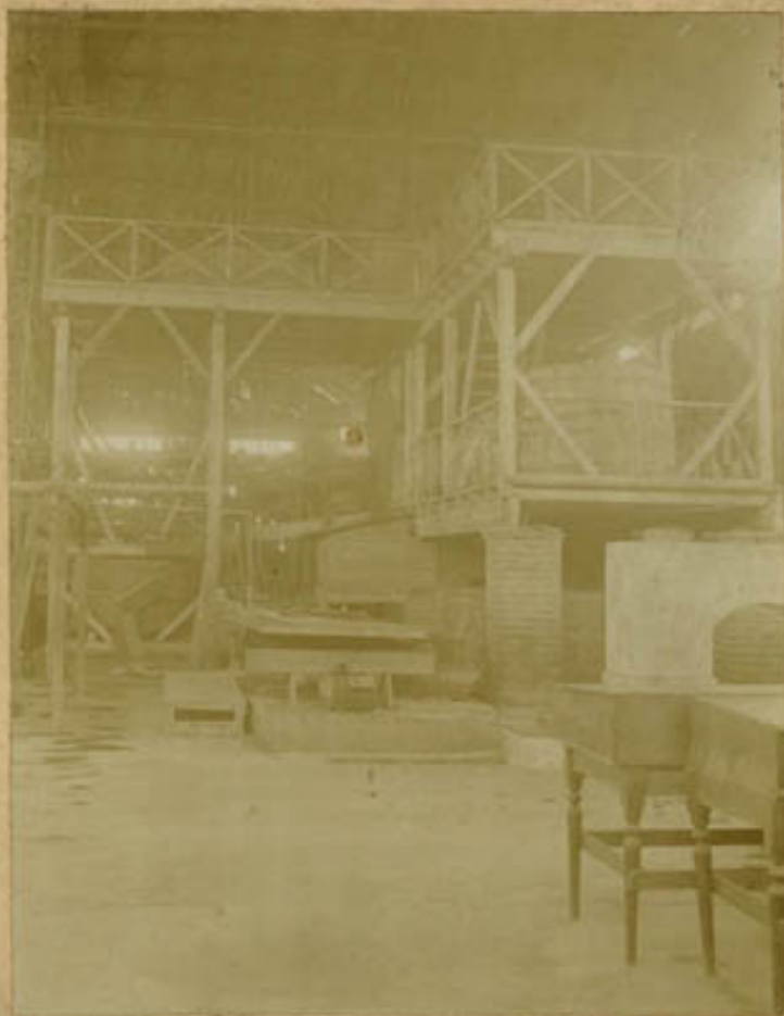
Establecimiento de Beneficio de minerales de Santiago (Saipín) Horno para destilar la pella, Binas para beneficio del Cobre por la vía húmeda, Casa tilfay para concentración fina, Motor eléctrico, Bina para beneficio del oro, sistema Littel.
