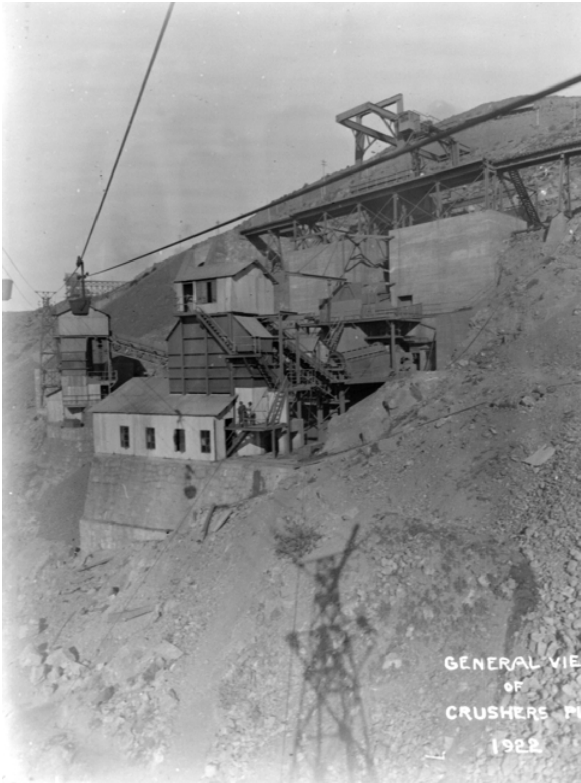
Vista General de Planta Trituradora
