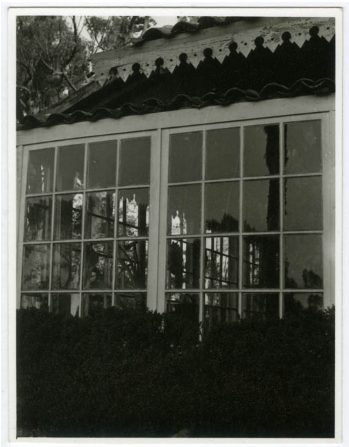
VENTANAL DE VIDRIO,HUALPEN, CONCEPCION
