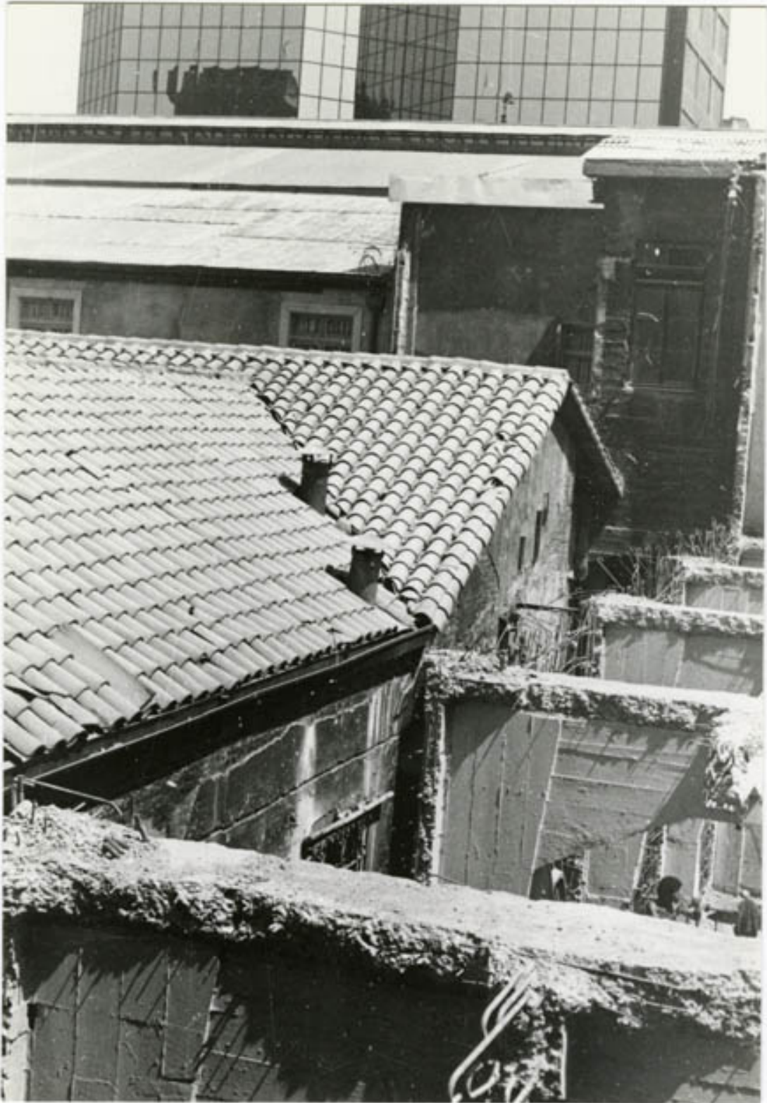
M.H.N.DEMOLICION EX CORREO
