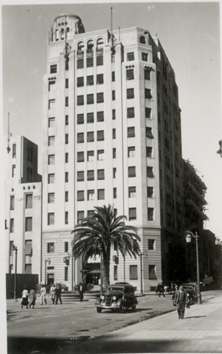
Santiago, (Chile) Edificio "Seguro Obligatorio"
