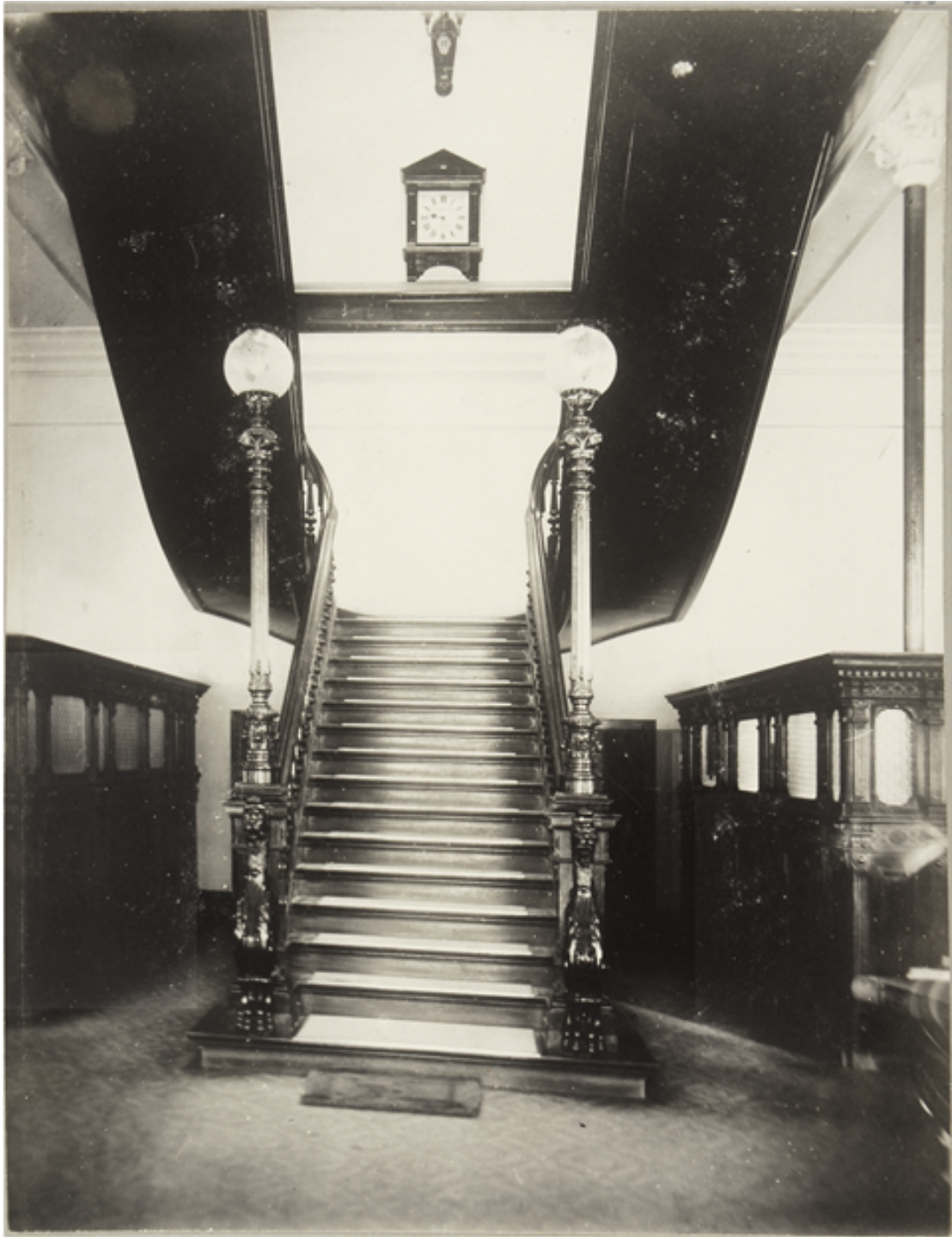
Edificio de la Compañía Sudamericana de Vapores de Valparaíso
