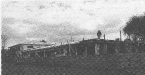
Antiguas dependencias aledañas a la Casa de Máquinas de Temuco serán remodeladas. Esta, por ejemplo, será el centro cultural "Sala Neruda".
