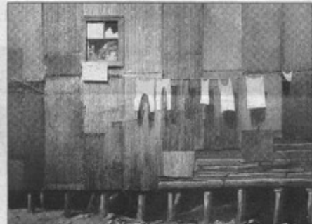
AMOR POR EL PUERTO.- Una imagen clásica captada en la pintura de Castro.
