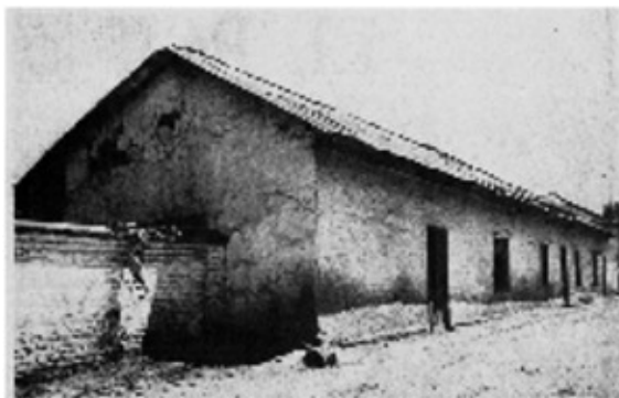
La Casa de la Cultura de San Juan de los Rios, en el departamento de Bolívar, construida por Enrique Campos Menéndez.
