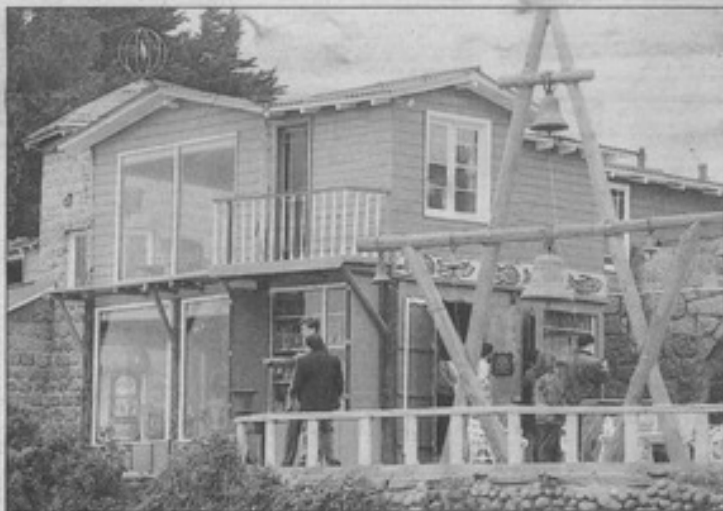
Una cantidad de casi 30 millones de pesos fue el costo de la reparación que tuvo la casa de Pablo Neruda en Isla Negra, la cual estará abierta a todo público desde la próxima semana.
