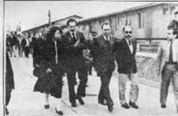
La entrega de viviendas por parte del gobierno es ampliamente insuficiente para paliar el déficit habitacional, según especialistas independientes
