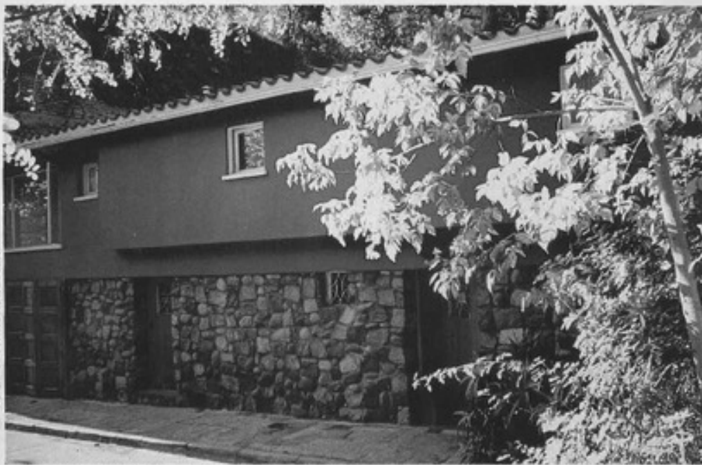
En 1953 se inicia la construcción de "La Chascona", con planos de los arquitectos Germán Rodríguez y Carlos Mainer, que Neruda modificó.
