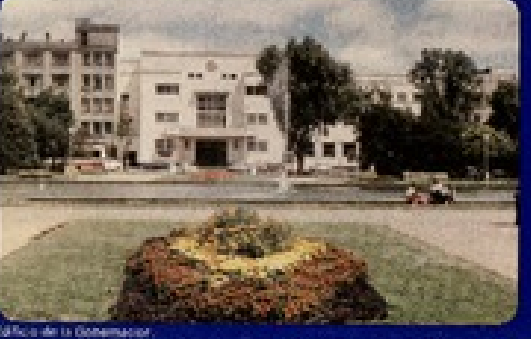
Edificio de la Gobernación
