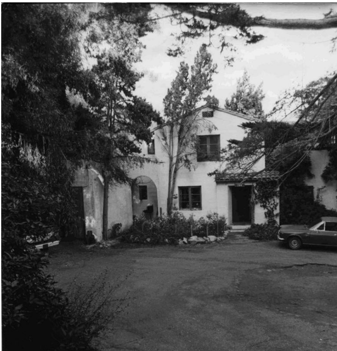
[Casa de Santa Bárbara] [fotografía].
