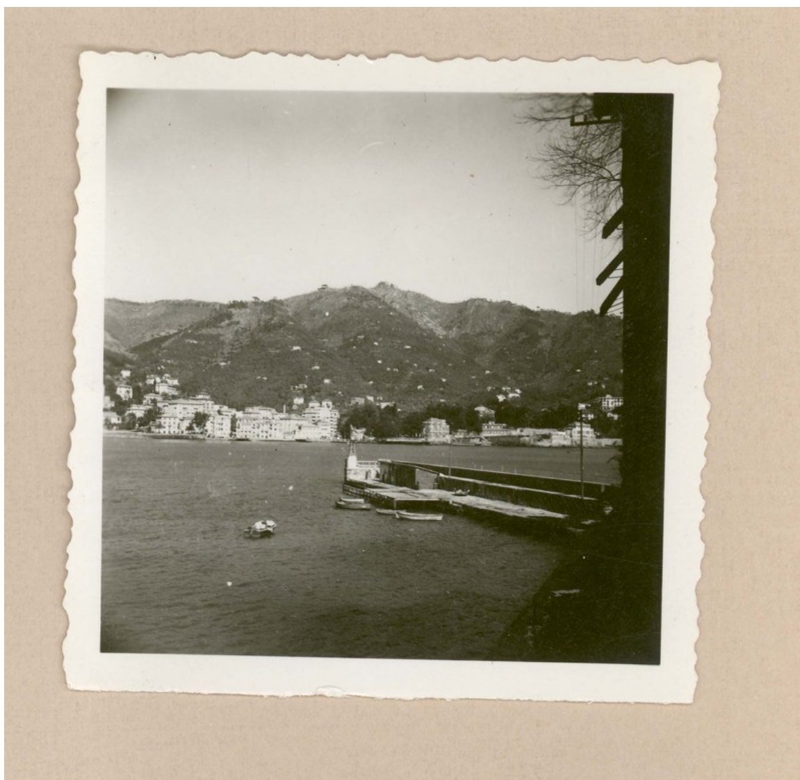
[Vista de Rapallo] [fotografía].
