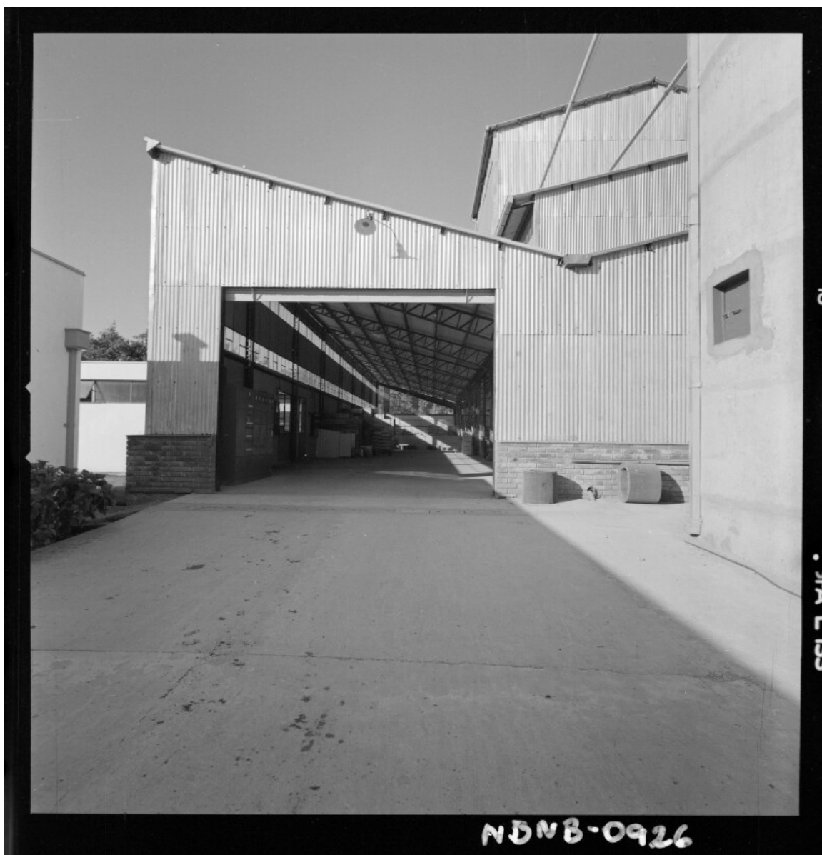
[Instalaciones industriales] [fotografía] Antonio Quintana.
