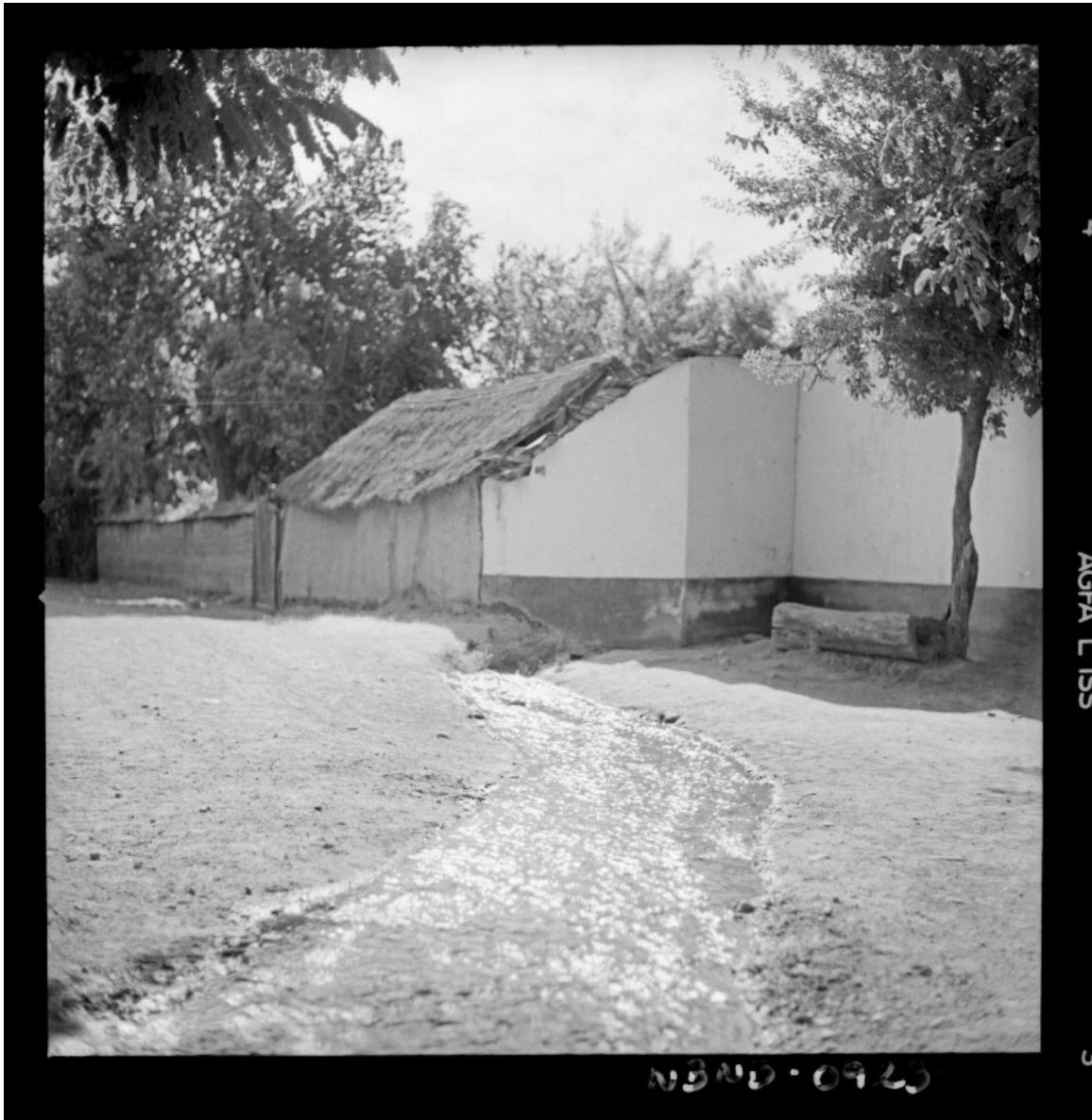
[Vista de pared exterior de casa] [fotografía] Antonio Quintana.
