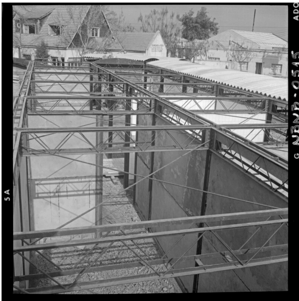
[Construcción de estructuras] [fotografía] Antonio Quintana.
