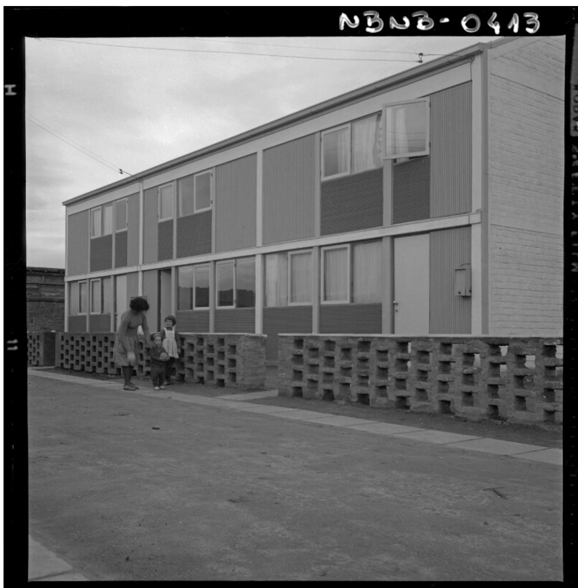
[Conjunto de viviendas] [fotografía] Antonio Quintana.
