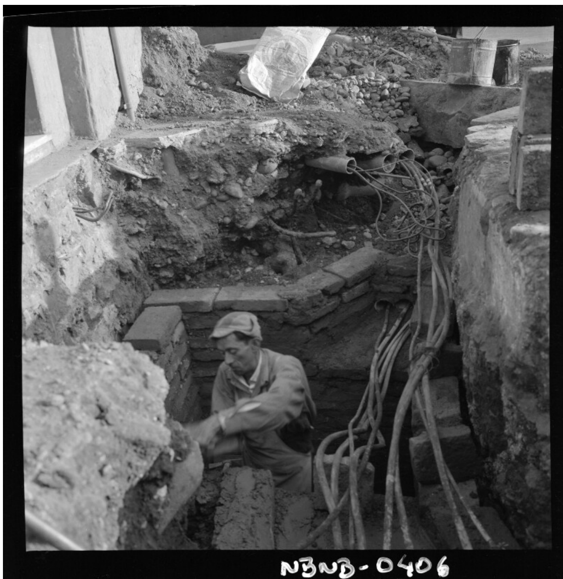
[Construcción de viviendas] [fotografía] Antonio Quintana.
