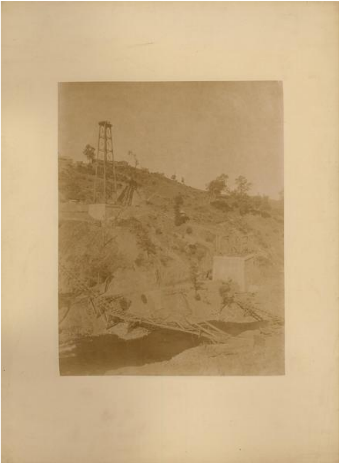
Construcción del viaducto de Malleco [fotografía].
