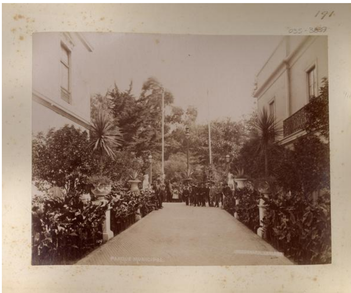
[Parque Municipal de Valparaíso, entrada principal] [fotografía] Fotografía Leblanc.
