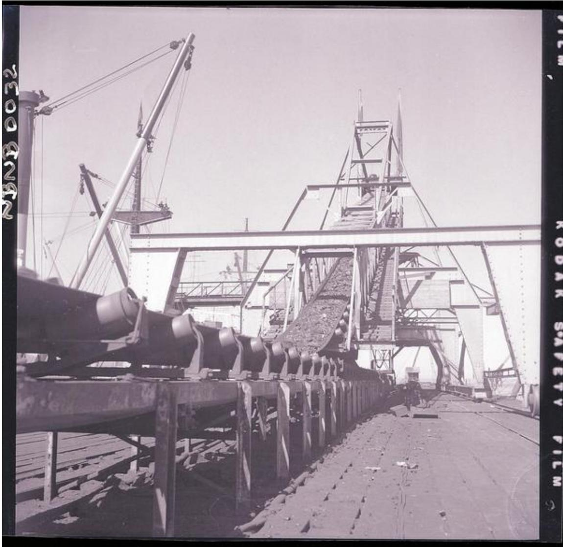
**[Carbón conducido por la cinta transportadora hasta el cargador móvil, instalado en el muelle de embarque; mina de carbón de Lota] [fotografía] Ignacio Hochhäusler.**
