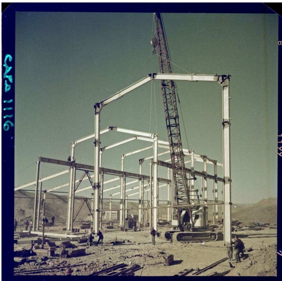
[Construcción de estructura metálica, mina "El Algarrobo"] [fotografía] Luis Ladrón de Guevara.
