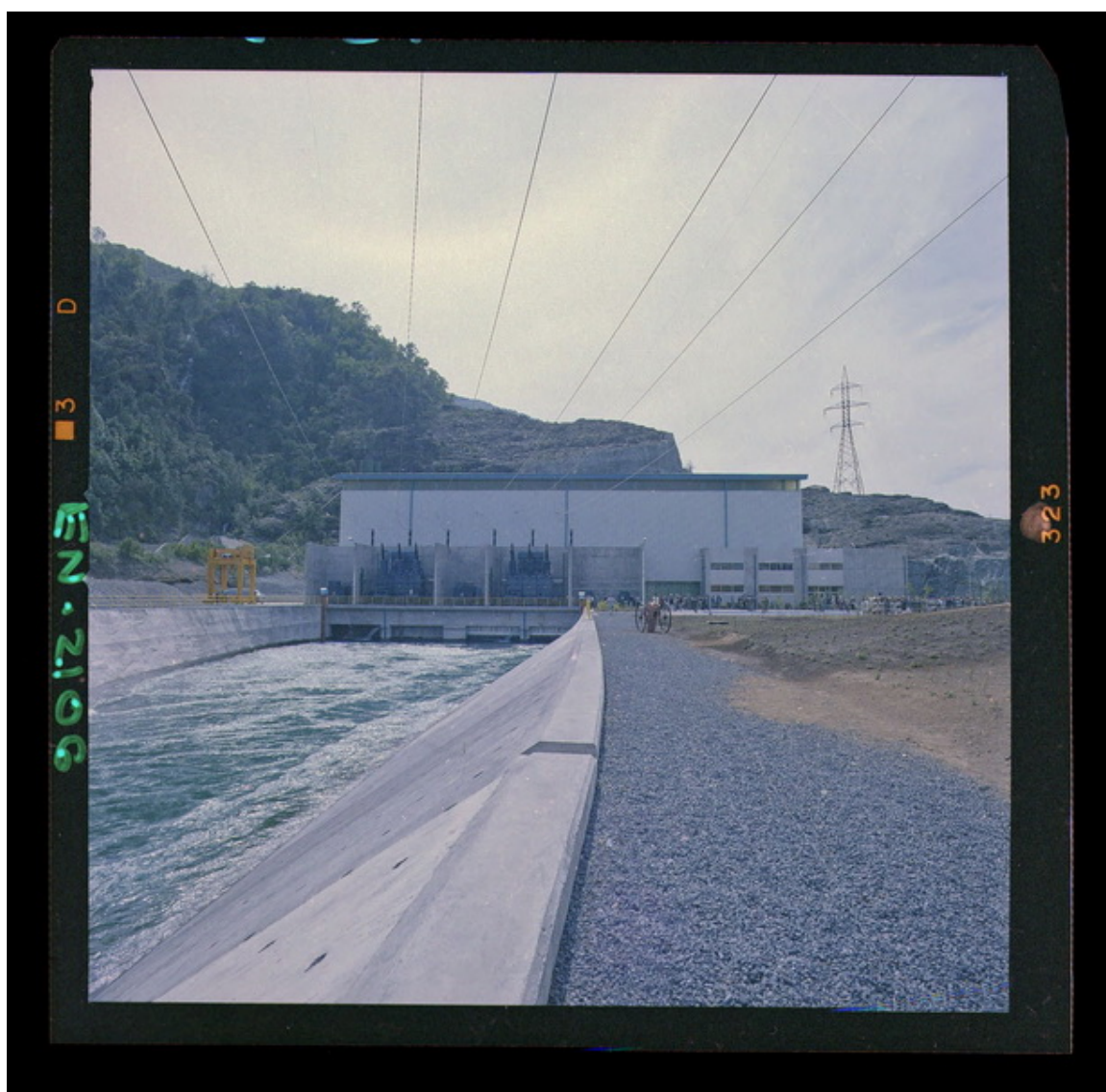
[Vista de la casa de máquinas, desde el canal de evacuación] : Inauguración de la Central Antuco, 22 de octubre de 1981 [fotografía] Luis Ladrón de Guevara.
