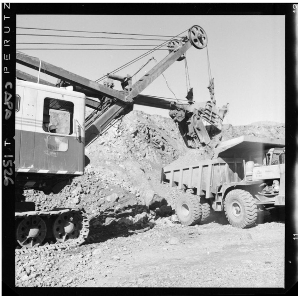
[Equipo de movimiento de tierras "LeTourneau - Westinghouse", exterior mina "El Algarrobo"] [fotografía] Luis Ladrón de Guevara.
