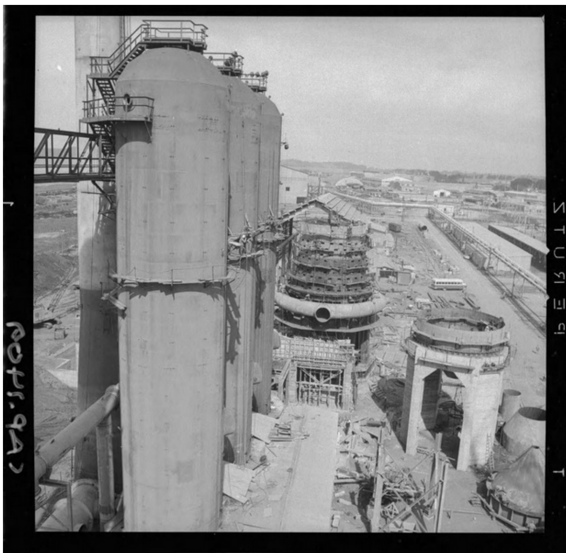
[Compañía de Acero del Pacífico : Planta Siderúrgica de Huachipato] [fotografía] Luis Ladrón de Guevara.
