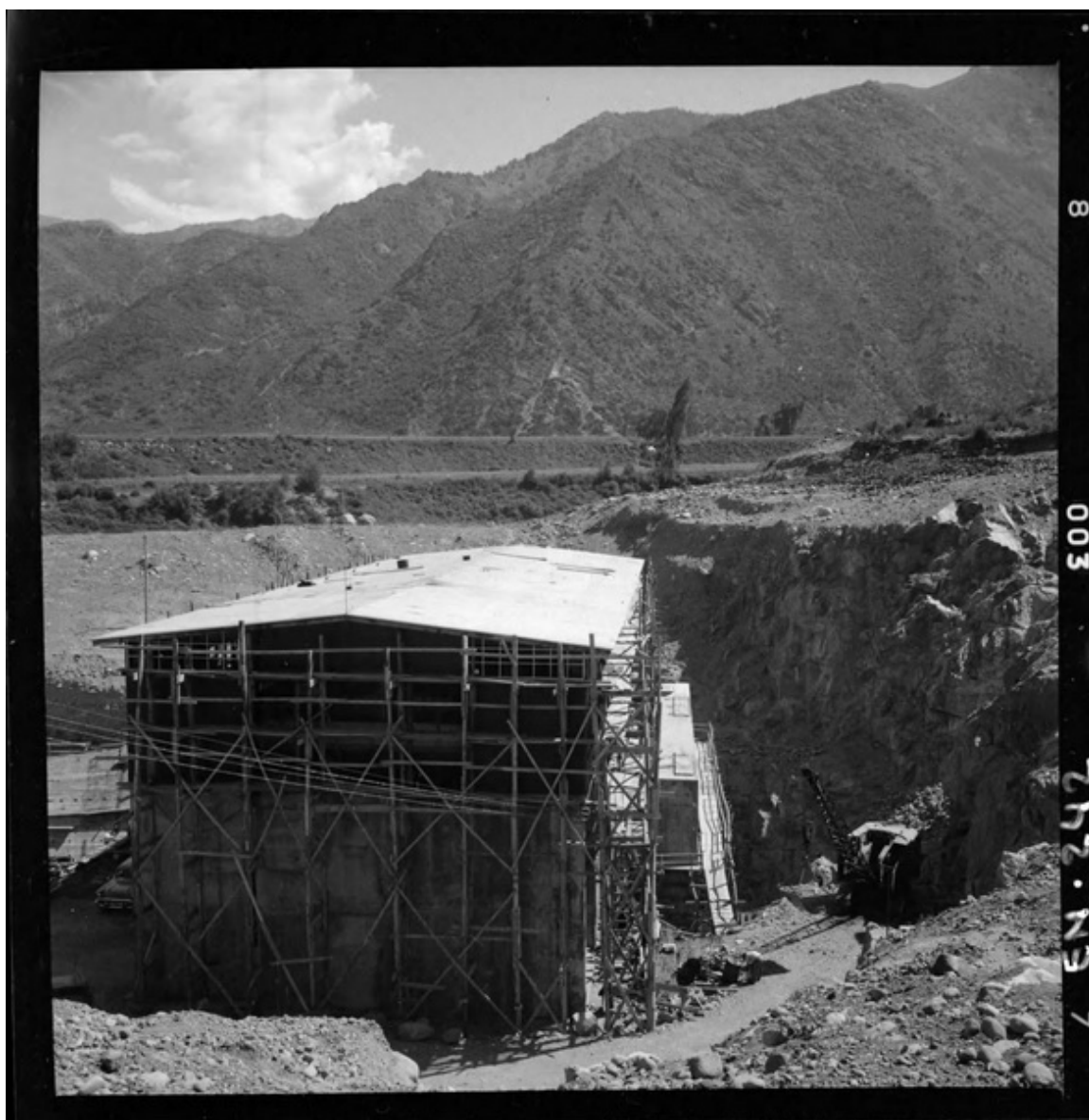
[Construcción de la casa de máquinas] [fotografía] Luis Ladrón de Guevara.
