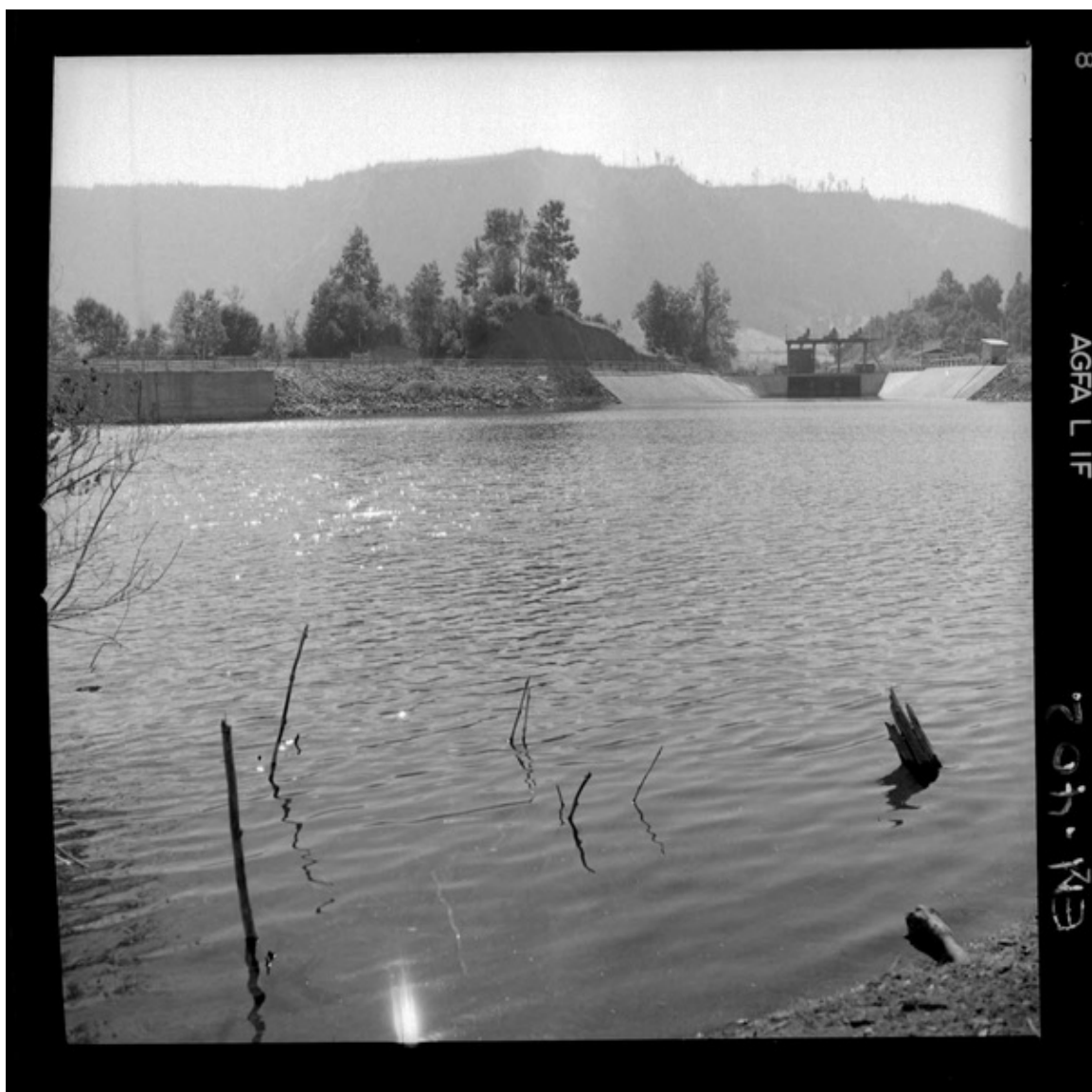
[Bocatoma ubicada en el desagüe de la laguna Pullinque] [fotografía] Luis Ladrón de Guevara.
