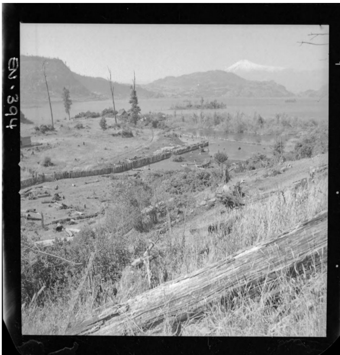
Central Hidroeléctrica "Pullinque" [fotografía] Luis Ladrón de Guevara.
