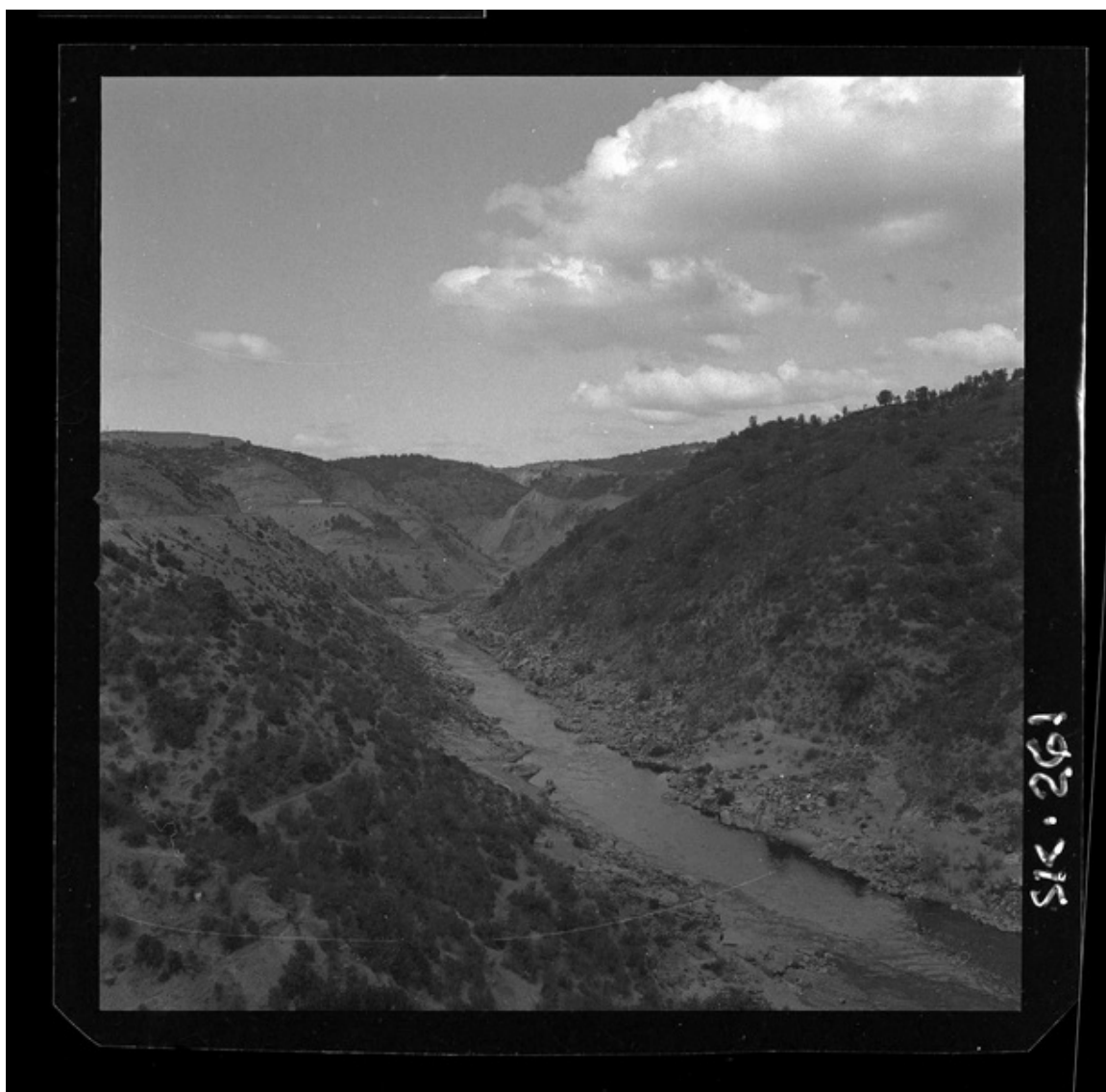
[Central Hidroeléctrica "Rapel"] [fotografía]
