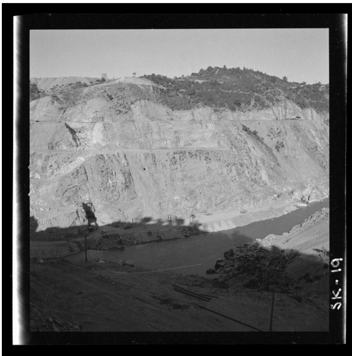
[Panorámica, construcción Central Hidroeléctrica "Rapel"] [fotografía] Luis Ladrón de Guevara.
